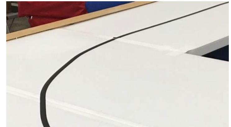
d) Conexiones terminadas con cinta de 2" y línea negra de cinta eléctrica
